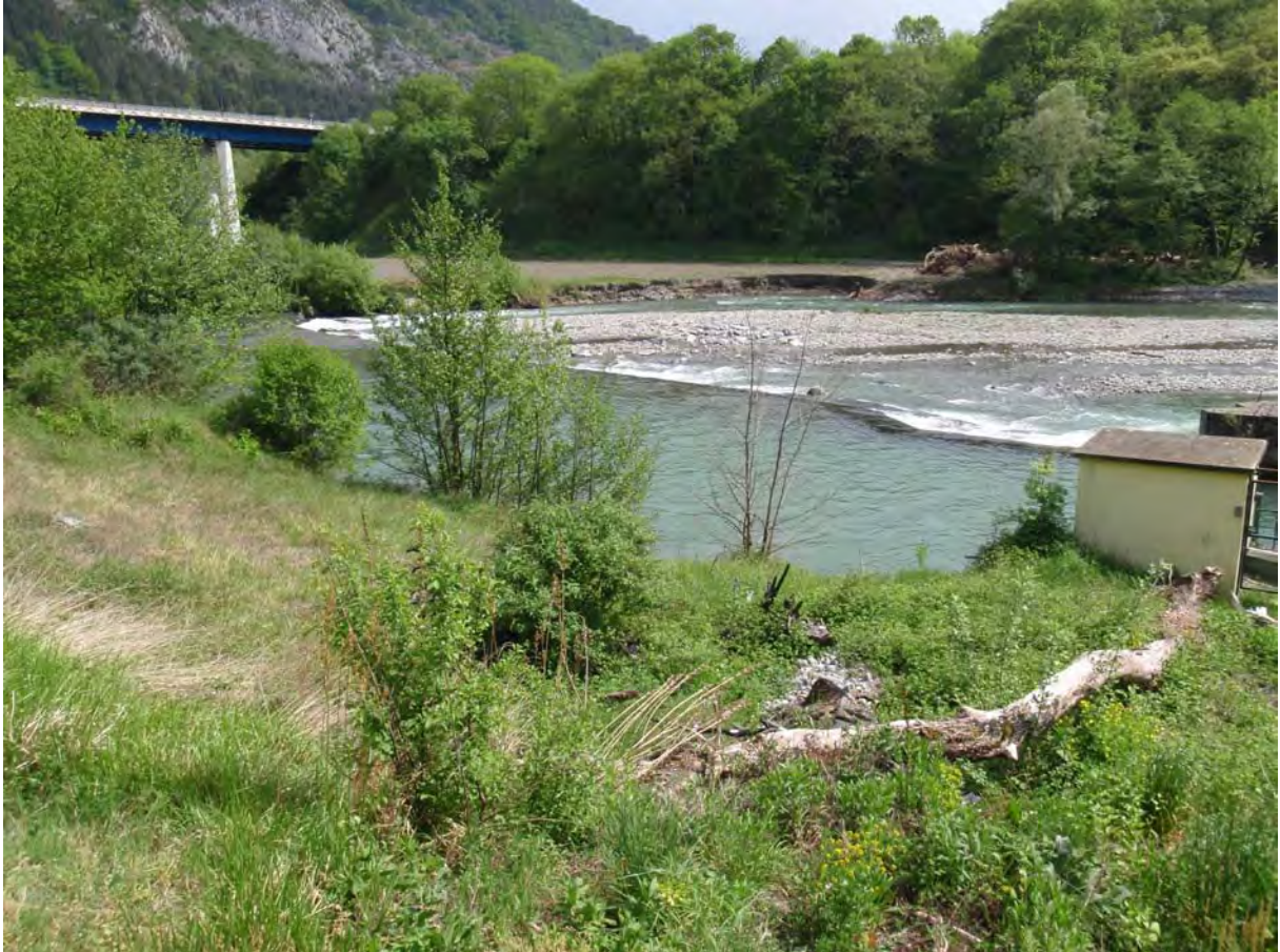
Illustration 10 : Le Gave de Pau à la centrale Latour (Lourdes)
