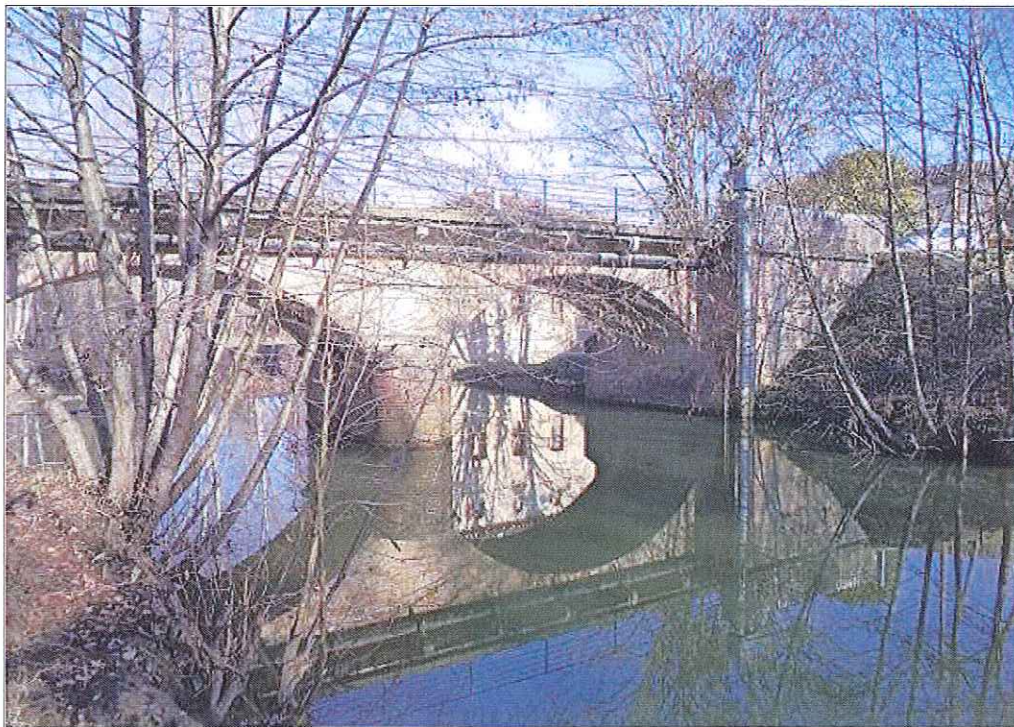
Figure n° 7 : Emplacement de la station DREAL à Saint-Nauphary
