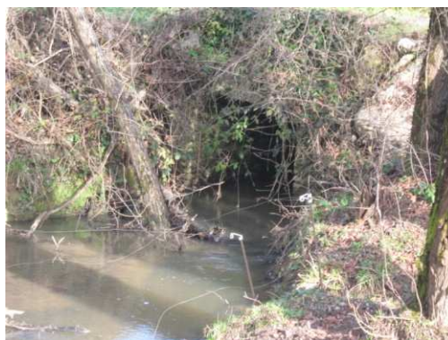
Ruisseau de Grate Vue aval passage busé – chemin des Caumonts
